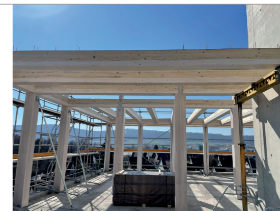
Neubau eines mehrgeschossigen Bürogebäudes für den Waldcampus der Hochschule in Aalen: Holzskelettbauweise mit Betonfertigteilelementen und vorgehängten Holzrahmenbauwänden.
