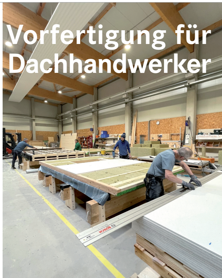
In der Vorfertigung gibt es eine 28 Meter lange Tischanlage zur Montage mit zwei Deckenkränen.
