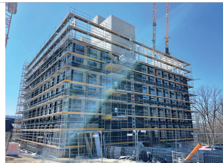
Neubau eines mehrgeschossigen Bürogebäudes für den Waldcampus der Hochschule in Aalen: Holzskelettbauweise mit Betonfertigteilelementen und vorgehängten Holzrahmenbauwänden.
